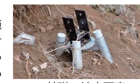
<基礎の拡大写真>
