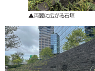
▲石垣と前面の植栽
