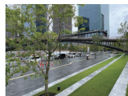
▲東西道路を越える橋
