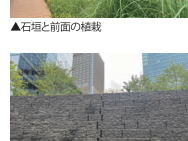
▲躯体構造が異なる境界部
